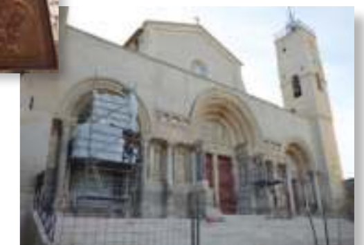
Restauration de l'abbatiale Saint-Gilles
