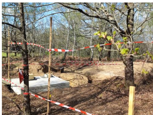
Travaux en cours des toilettes sèches Livinhac le Haut au Tabor
